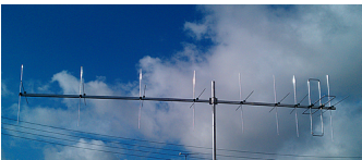
A single 18el (9+9) el X-POL LFA Yagi
